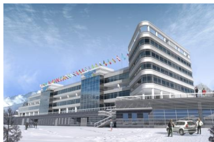
| Совмещенный комплекс для проведения соревнований по лыжным гонкам и биатлону
