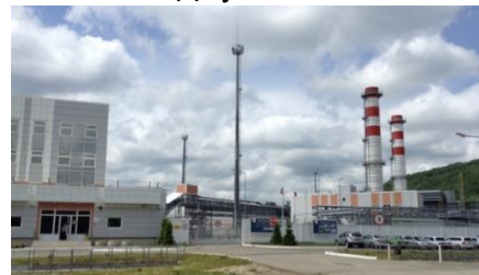
| Модернизация энергетической системы на базе ТЭС «Джубга»
